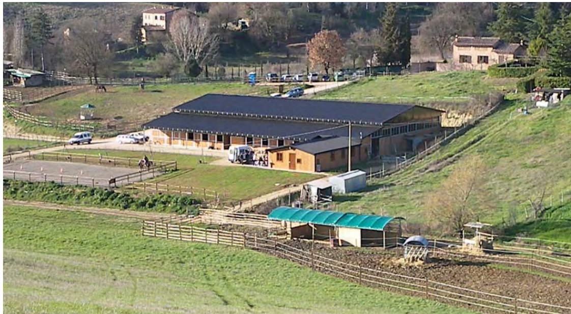
Le strutture del centro Le Bollicine presso l’Agresto
