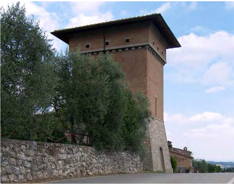
Sopra e a lato impianti di deposito idrico, presso Barontoli e a Sovicille
