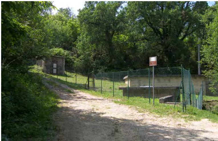
Opere di presa della sorgente del Busso presso Torri.
