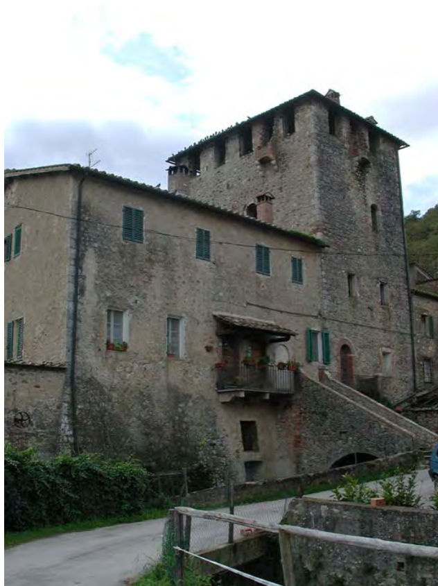
Il Molino del Pero presso l'abitato di Brenna, il primo dei grandi mulini fortificati del medioevo.
