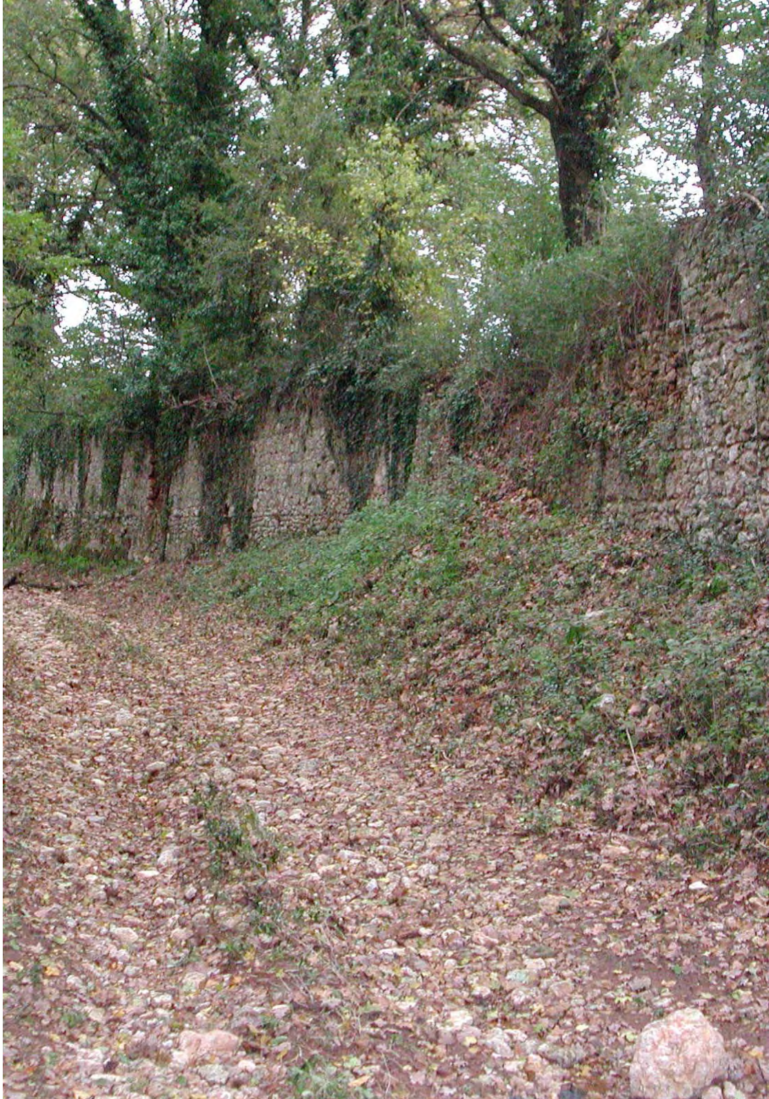
Un tratto del fosso Arnano dove sono evidenti le imponenti opere di regimazione idraulica con realizzazione di muri di contenimento in pillole di fiume che si elevano oltre il piano di campagna e piantata di querce lungo il suo argine. Tali interventi nel loro insieme vanno a costituire un rilevante segno del paesaggio del Piano di Rosia.
