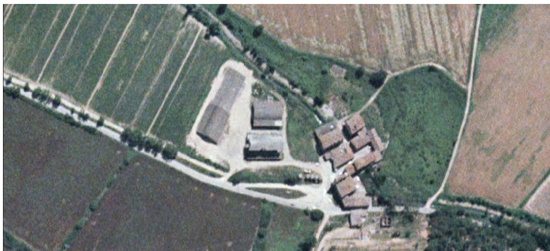
Due immagini delle strutture in disuso presso Serravalle
