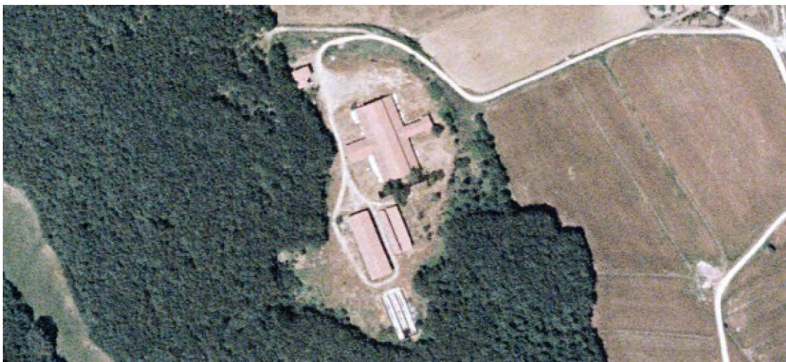
Il complesso in disuso dell'allevamento presso Poggiaccio
