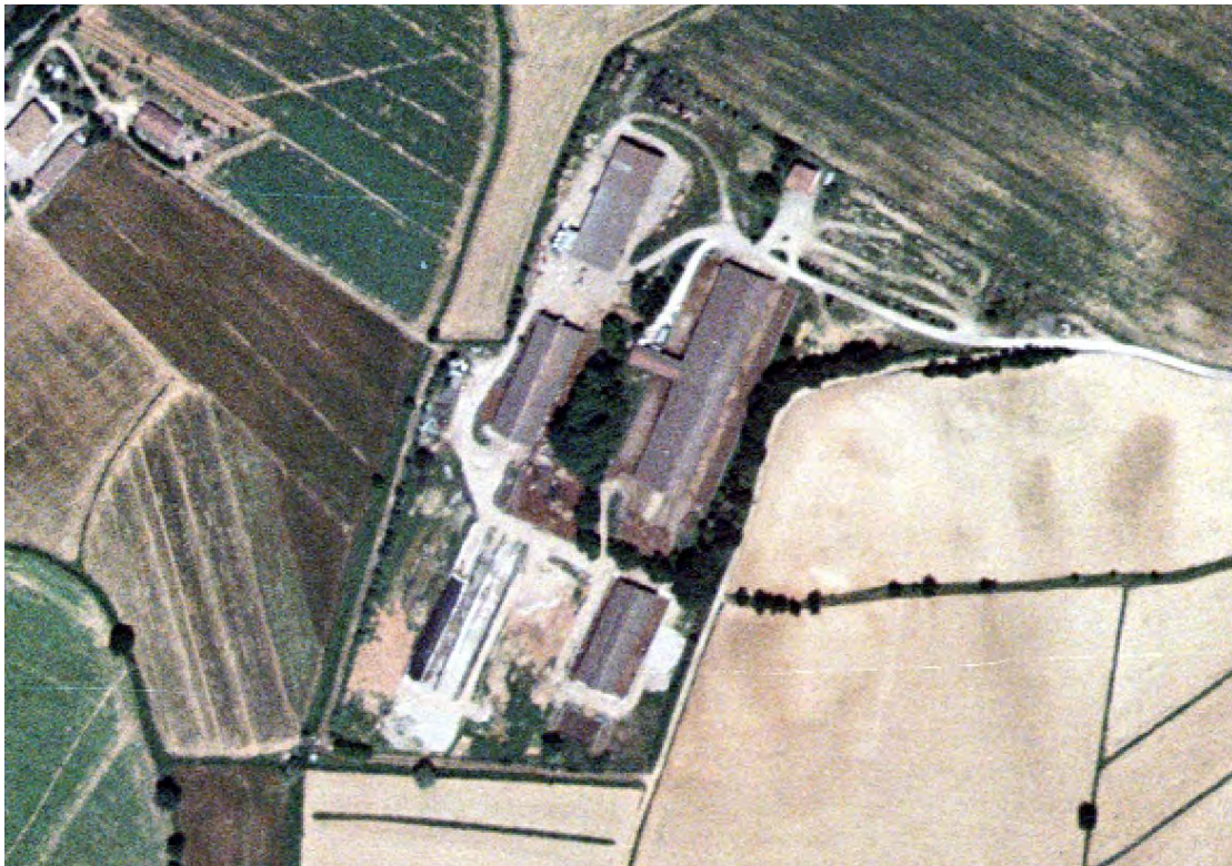
Il complesso della Stalla sociale presso Ampugnano
