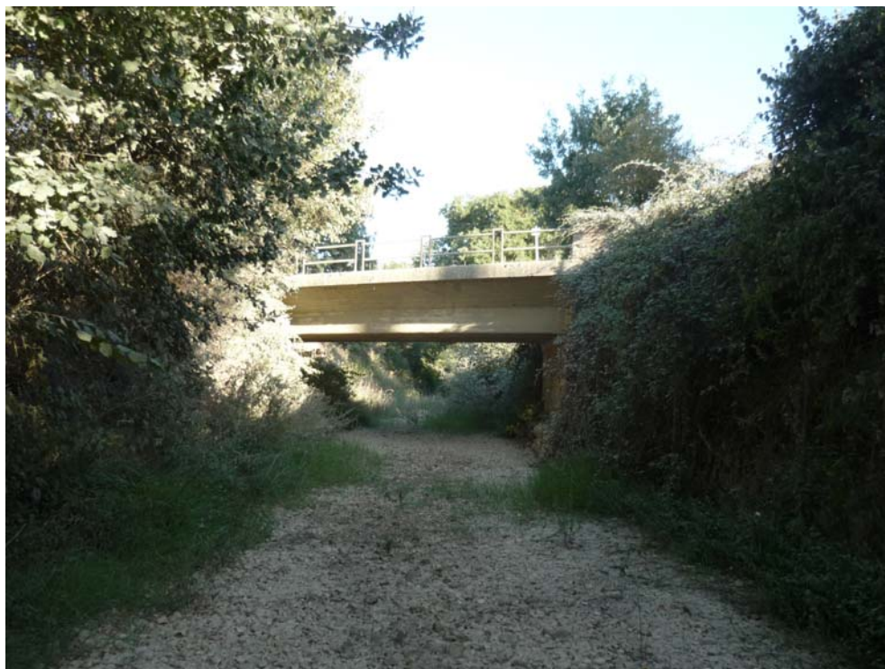
Foto 2 – T. Rosia, attraversamento S.C. del Padule sezione RO 1.8
