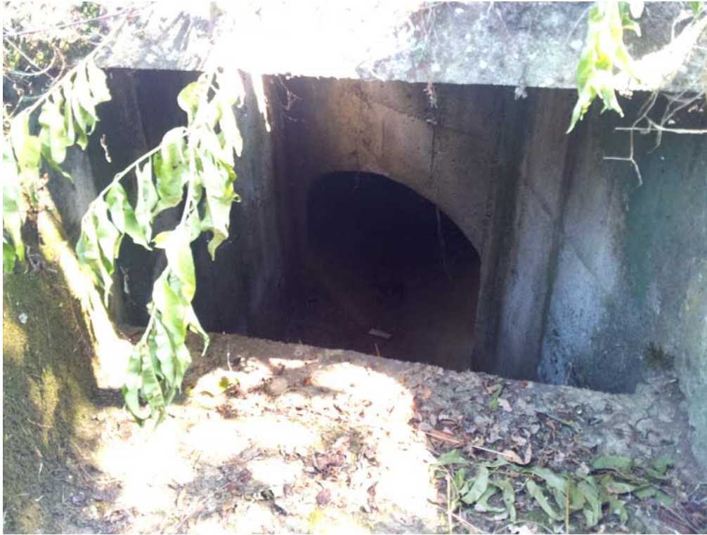
Foto 15 - vista dell'imbocco del tratto scatoato del Fosso del Doccino (attraversamento SP 99)
