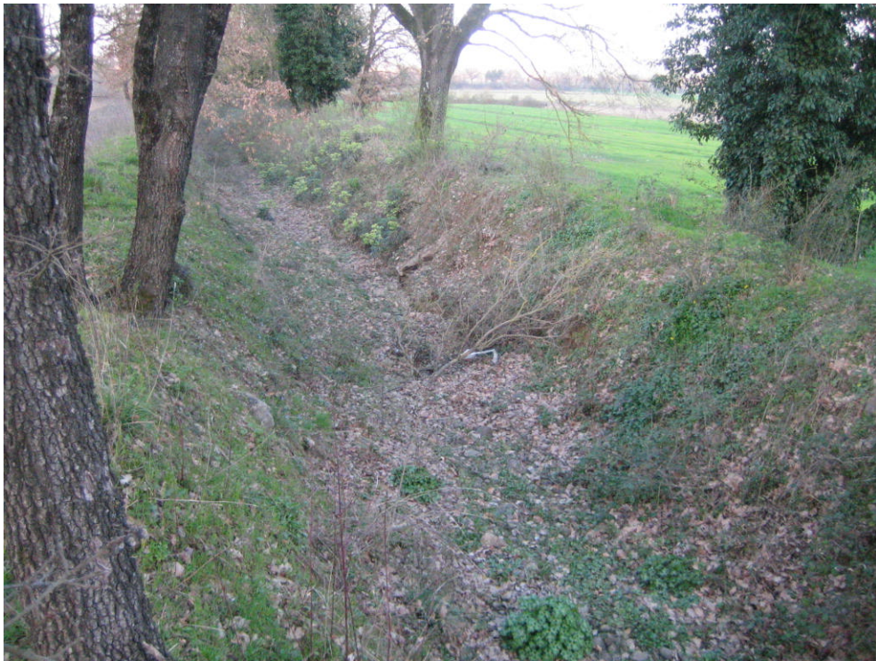
Foto 18 – F.sso di Canale, vista a monte della sezione CA 3
